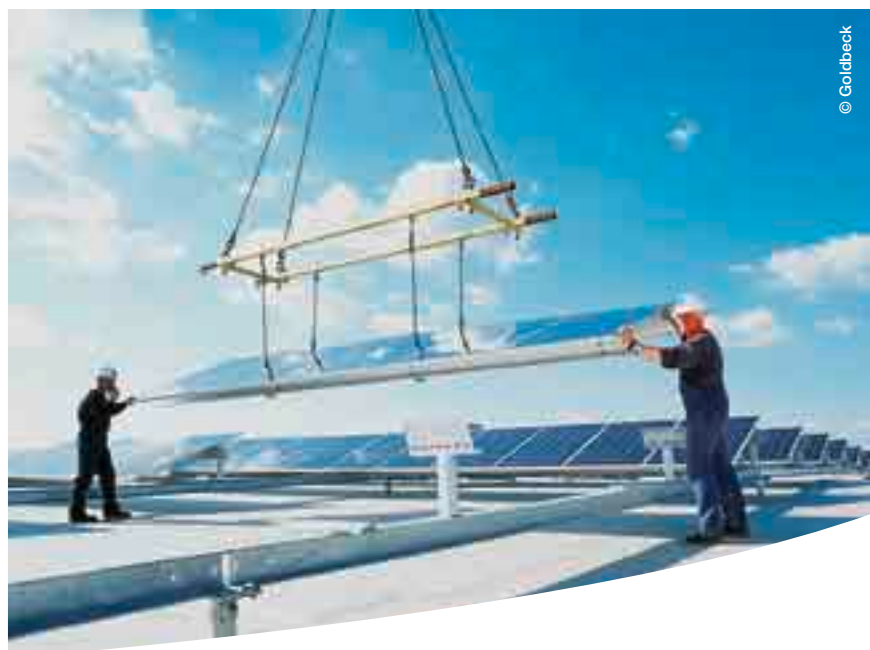
Instalación de módulos en el tejado de un edificio
