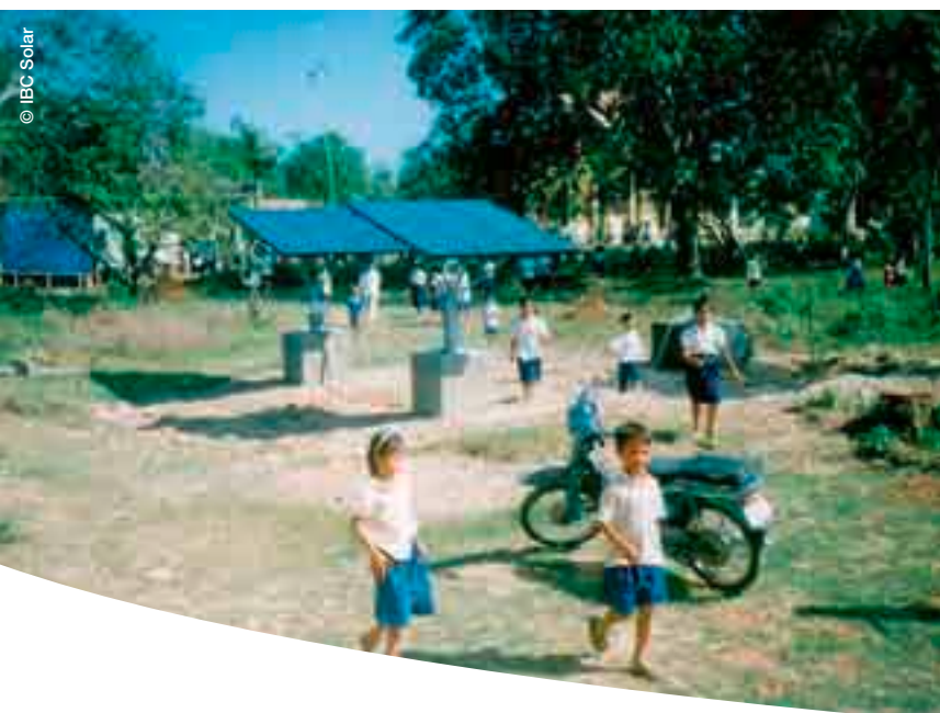
Sistema FV en una escuela de Camboya
